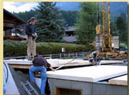
Kellerdecke aus 5-schichtiger KLH - Platte (146mm).
