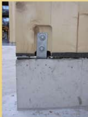
Anschluss KLH-Wand betonierter Sockel. Konstruktiver Holzschutz im Hallenbau.
