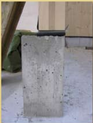
Anschluss KLH-Wand betonierter Sockel. Konstruktiver Holzschutz im Hallenbau.
