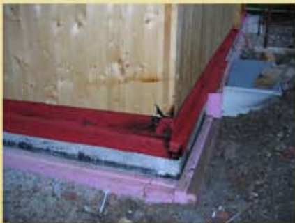
Übergang Kellerdecke und KLH - Wand (zurückspringend) geflämmt.
