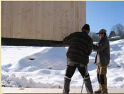
Anbringen der Mauerwerkssperre (gegen Aufsteigende Feuchtigkeit, bei betonierter Kellerdecke).
