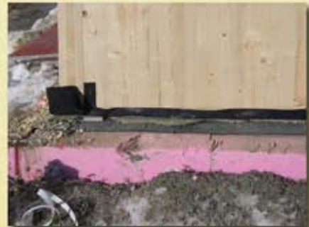
Anschluss KLH - Wand betonierte Kellerdecke. Auflage auf Kunststoffunterleger und vollflächigem Quellmörtel.
