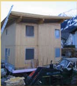
Dämmung Dach Hofatex
