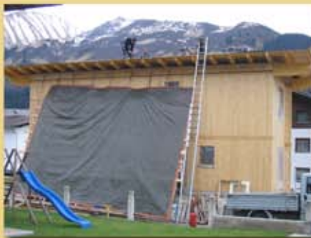
Flächen Flachdach Passivhaus
