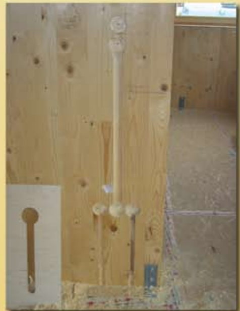
Schablone und Schlitze für Leerrohre.
