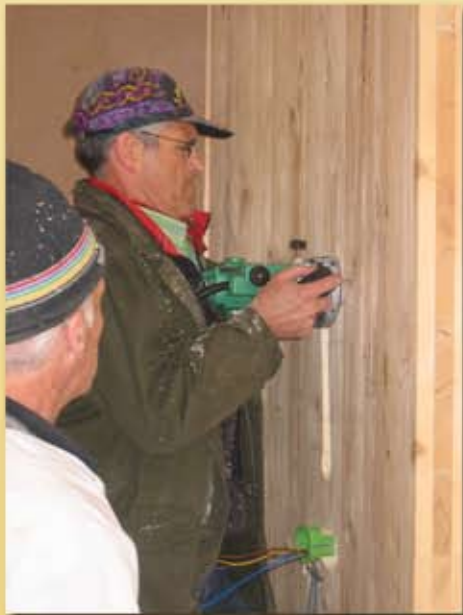
Fräsen der Schlitze für Leerrohre.
