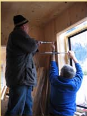
Befestigung Riegel KLH-Wand.
