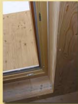
Anschluss KLH Wand Riegel-Fenster.
