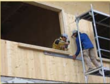
Setzen Riegel-Konstruktion.
