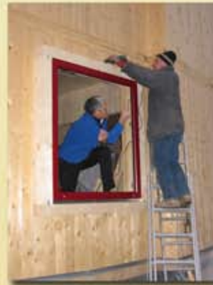
Dichtband für Winddichtheit Riegel KLH-Wand.
