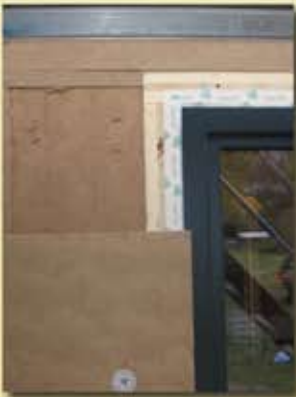
Überdämmerter Fensterstock.
