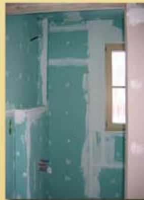
Vorsatzschale Waschbecken, Bad.
