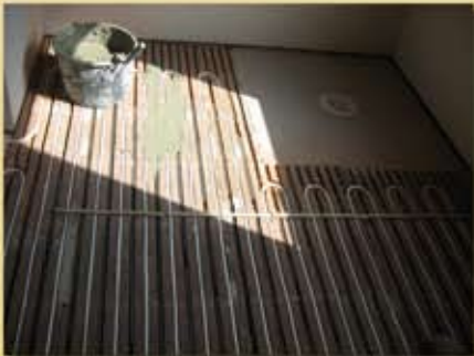
Fussbodenheizung
