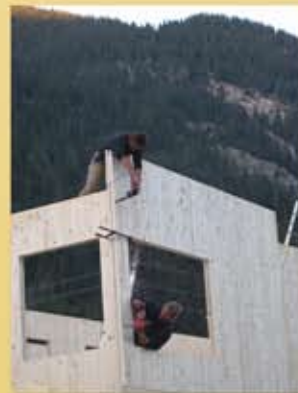
Verschraubung Ausseneck
