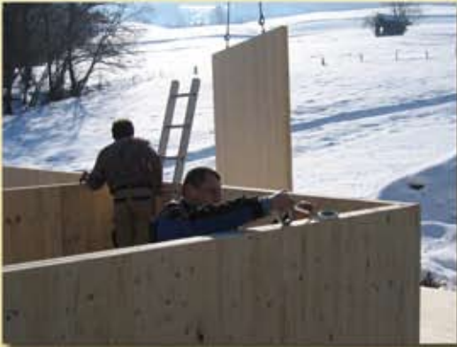
Anbringen Dichtbänder Winddichtheit KLH - Wand mit KLH - Decke
