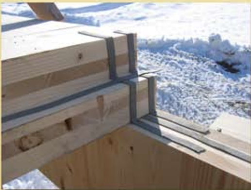
Detail Winddichtheit im Stufenfalz der KLH-Decke.
