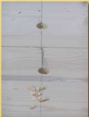
Verschraubung Deck - Wand
